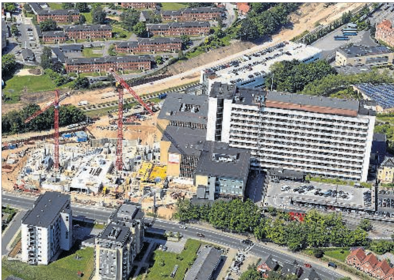
Byggekranerne har travlt ved tilbygningerne til Regionshospitalet i Viborg. Ombygningen har man af praktiske hensyn forskudt. (Foto: Regionshospitalet Viborg)
