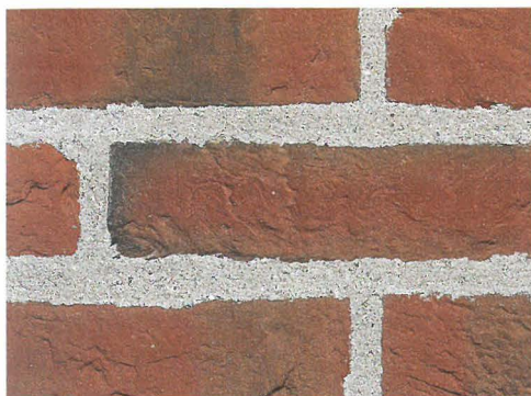
Figur 3.9. Håndstrøgne sten. Håndstrøgne sten har en lidt uregelmæssig overflade. Bl.a. har de vandlæg der, hvor leret ikke helt har udfyldt formen.
