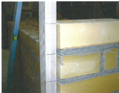
Figur 9.10. Kontrol af højdemål ved hjælp af højdelægte.
