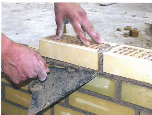
Figur 10.35. Overskydende mørtel skræbes af.
