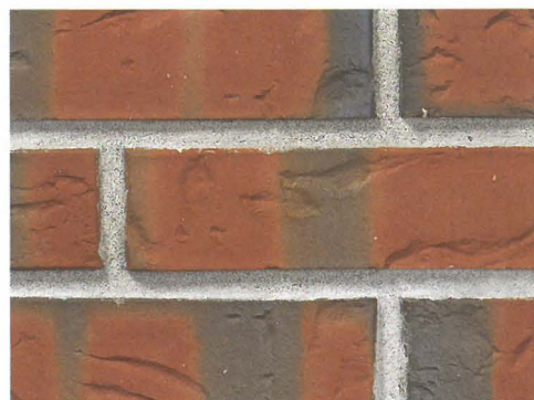
Figur 3.12. Strengpressede sten (maskinsten) med dybt præg.
