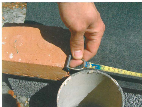
Figur 9.6. Det er vigtigt, at der måles til samme side af stenen – fra højre kant af en sten til højre kant af den næste sten.
