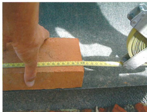
Figur 9.6. Det er vigtigt, at der måles til samme side af stenen – fra højre kant af en sten til højre kant af den næste sten.
