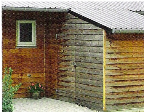
Figur 30 Udhæng medfører betydelige farveforskelle på ubehandlede facader forårsaget af sol og regn.
