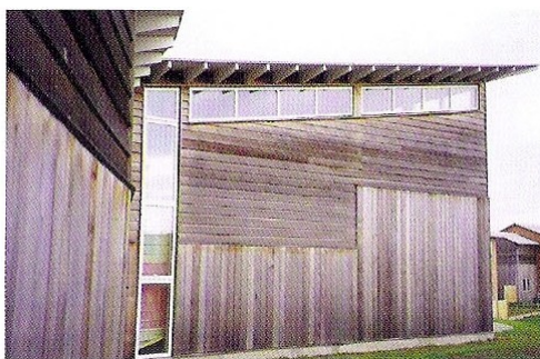
Figur 32 Frilagte facader vil patinere forskelligt betinget af vejrliget, placering i forhold til verdenshjørnerne samt lokale forhold.
