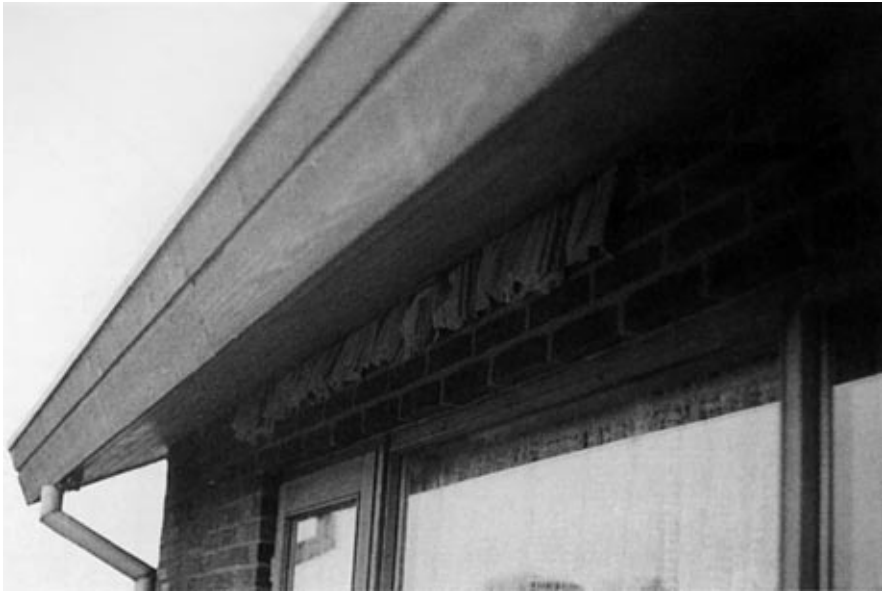
Figur 5. Den lodrette forankring af dette tag var ikke tilstrækkelig, så under en kraftig storm lettede taget en smule, men det faldt på plads igen. Gardinet og tagedløbet bevidner hændelsen.
