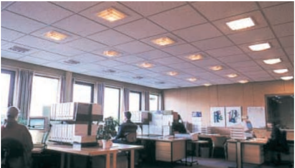
Eksempel på zoneopdeling. Læg mærke til lysstyrken i armaturerne. Dem ved vinduet er slukket.
