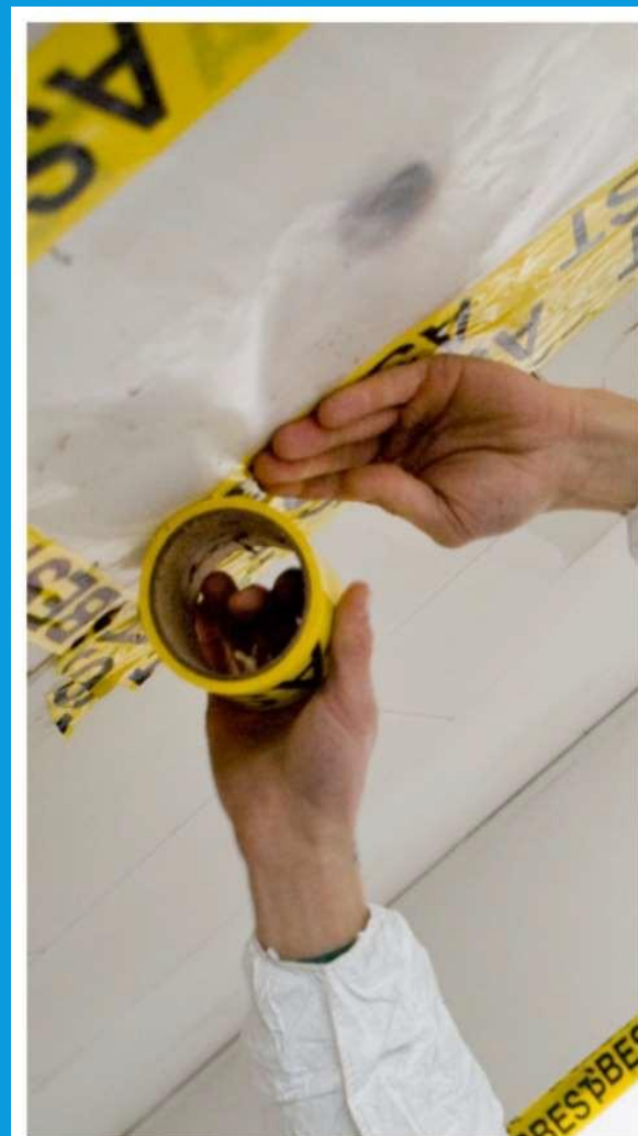
Afdækning inden opstart
