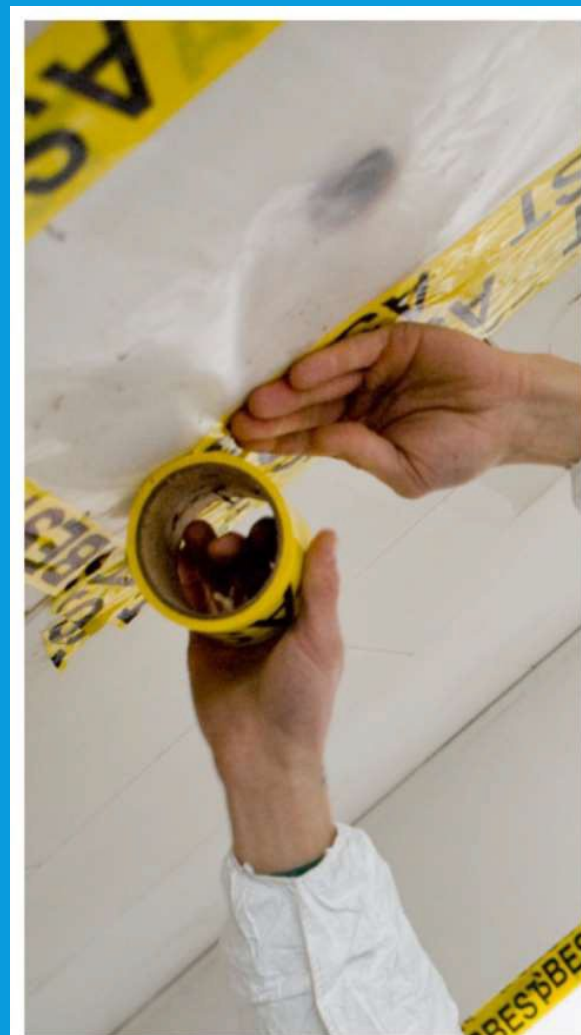
Afdækning inden opstart
