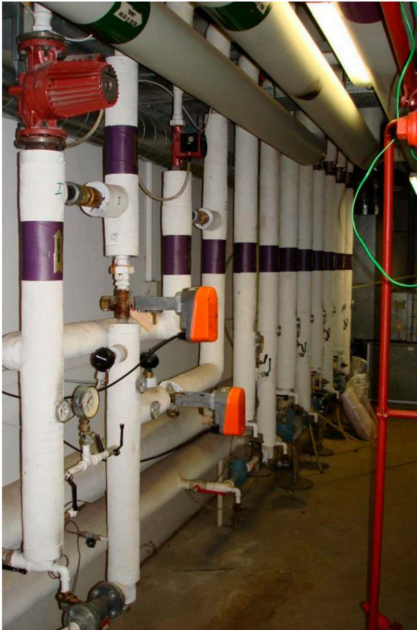
Figur 1. Isolering af rør til radiatorer
