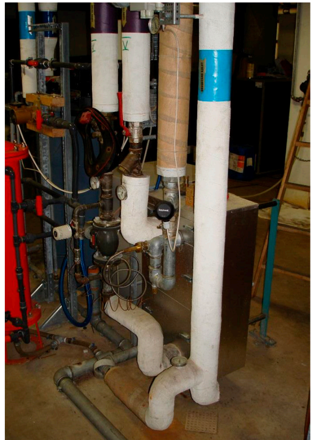
Figur 2. Gennemstrømningsvandvarmer i varme-central
