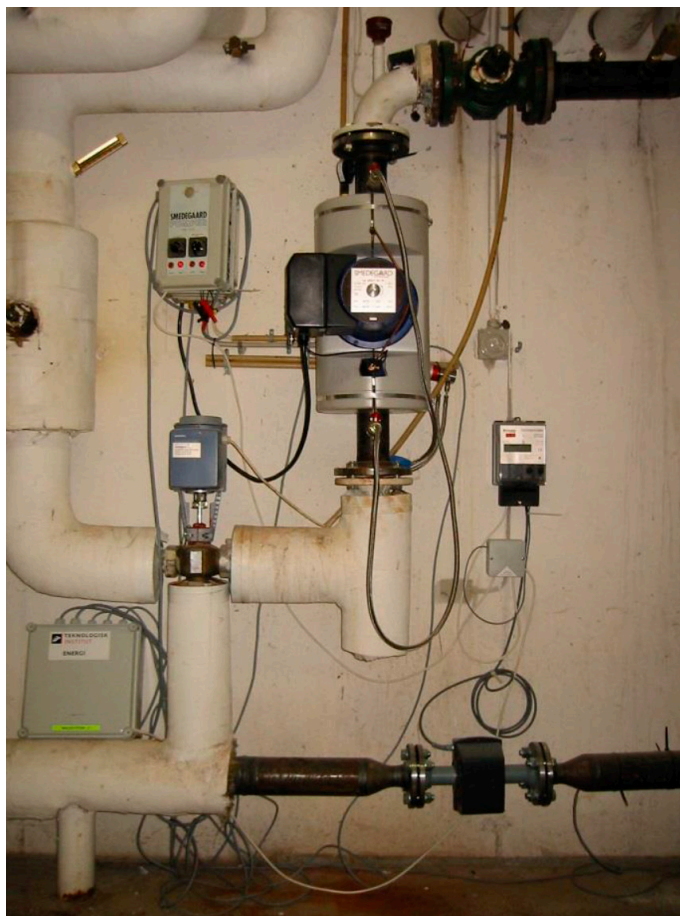
Figur 3. Præfabrikeret isoleringskappe på cirkulationspumpe
