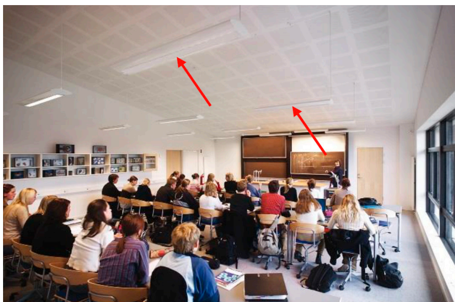
Figur 12. Zoneopdeling af belysningsanlæg. Armaturerne i højre side af lokalet er slukkede mens armaturerne til venstre er tændt. (Kilde: https://installator.dk/store-besparelser-med-lysstyring )
