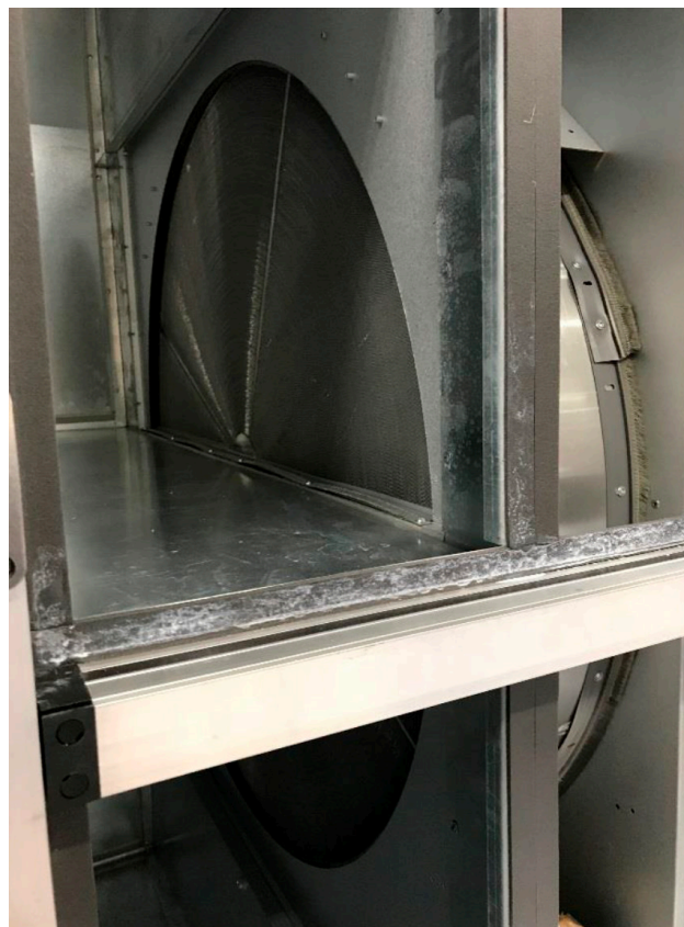
Figur 5. Energieffektiv roterende veksler
