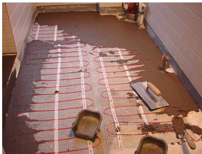
Figur 7. Elektrisk gulvvarme (varmemåtte)
