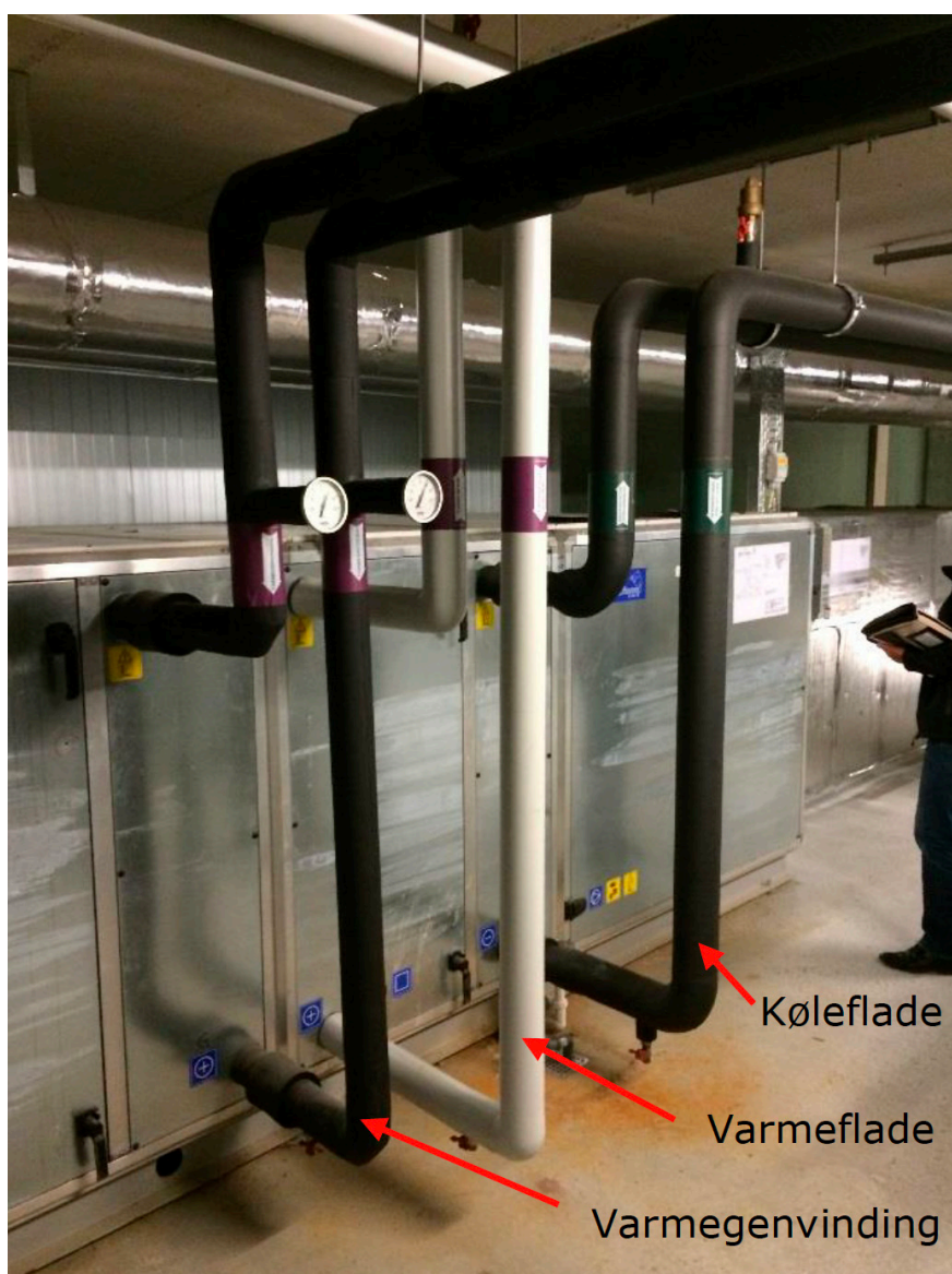
Figur 1. Komfortanlæg med varmegenvinding samt varme- og køleflade
